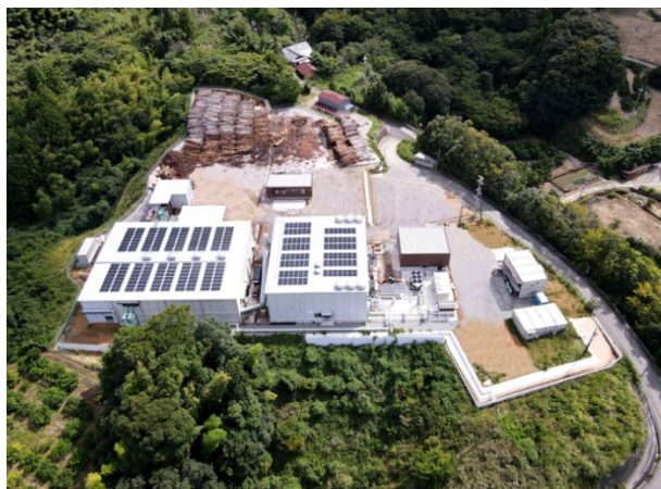
有田川バイオマス発電所
