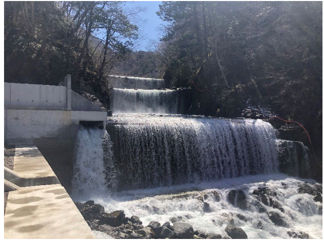
●取水部（既設堰堤）
