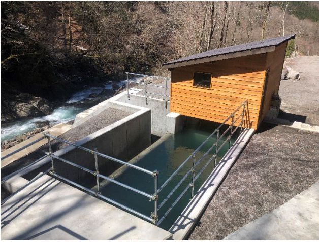
●水槽と除塵機建屋
