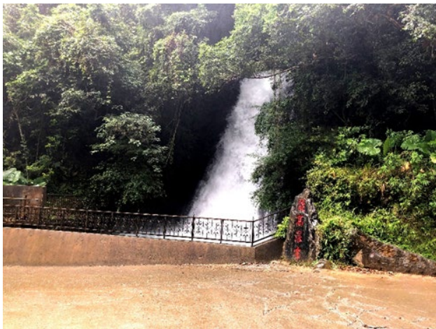
能高大圳小水力発電所_取水下流部の滝
