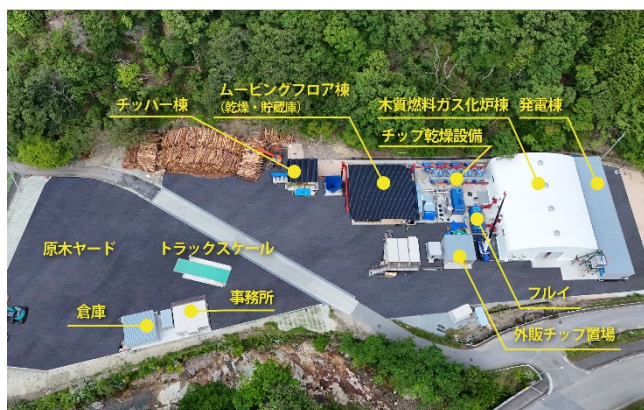
生野銀山バイオマス発電所 全景
